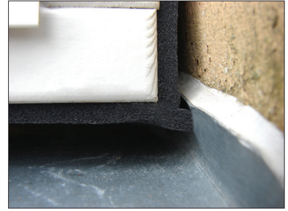
9. Pressa de två fogbanden mot varandra.
