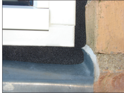
10. Efter expansionen är fogen helt tät.
