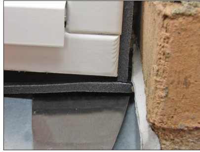
8. Det vågräta fogbandet monteras och trycks ihop med den lodräta biten (se bild 8).
