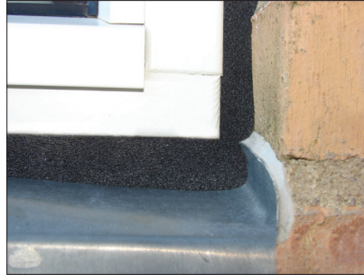
10. Efter expansionen är fogen helt tät.
