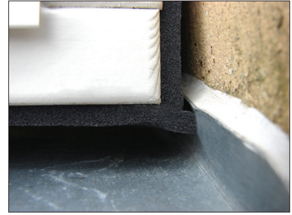
9. Pressa de två fogbanden mot varandra.
